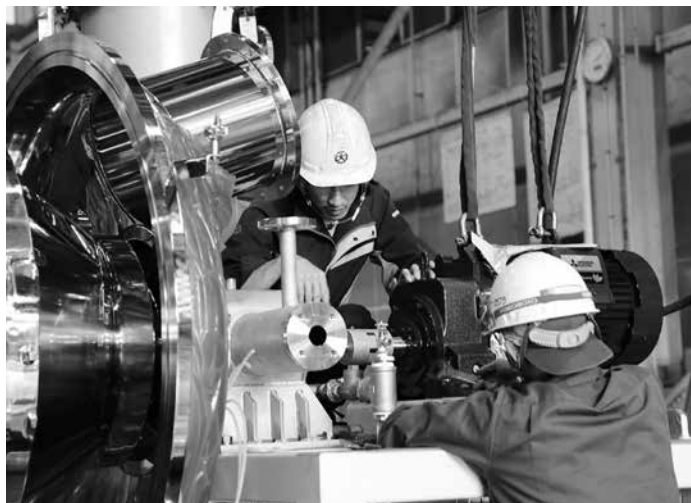
▲産業装置の開発・製造から据付、メンテナンスまで一貫したサービスを提供
